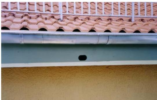
Abb.5: Dr. S. Salinger „Nistkasten-Konstruktion für Mauersegler – im Traufkasten“
