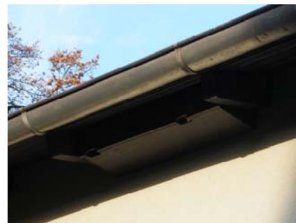
Abb.4: R. Tantau „Nistkasten für Mauersegler unter der Dachtraufe, farblich angepasst – in Kastenform“
